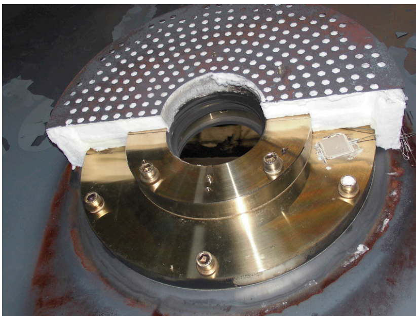
Abb. 6: Feuerfeste Schottabdichtung nach Brandtest
